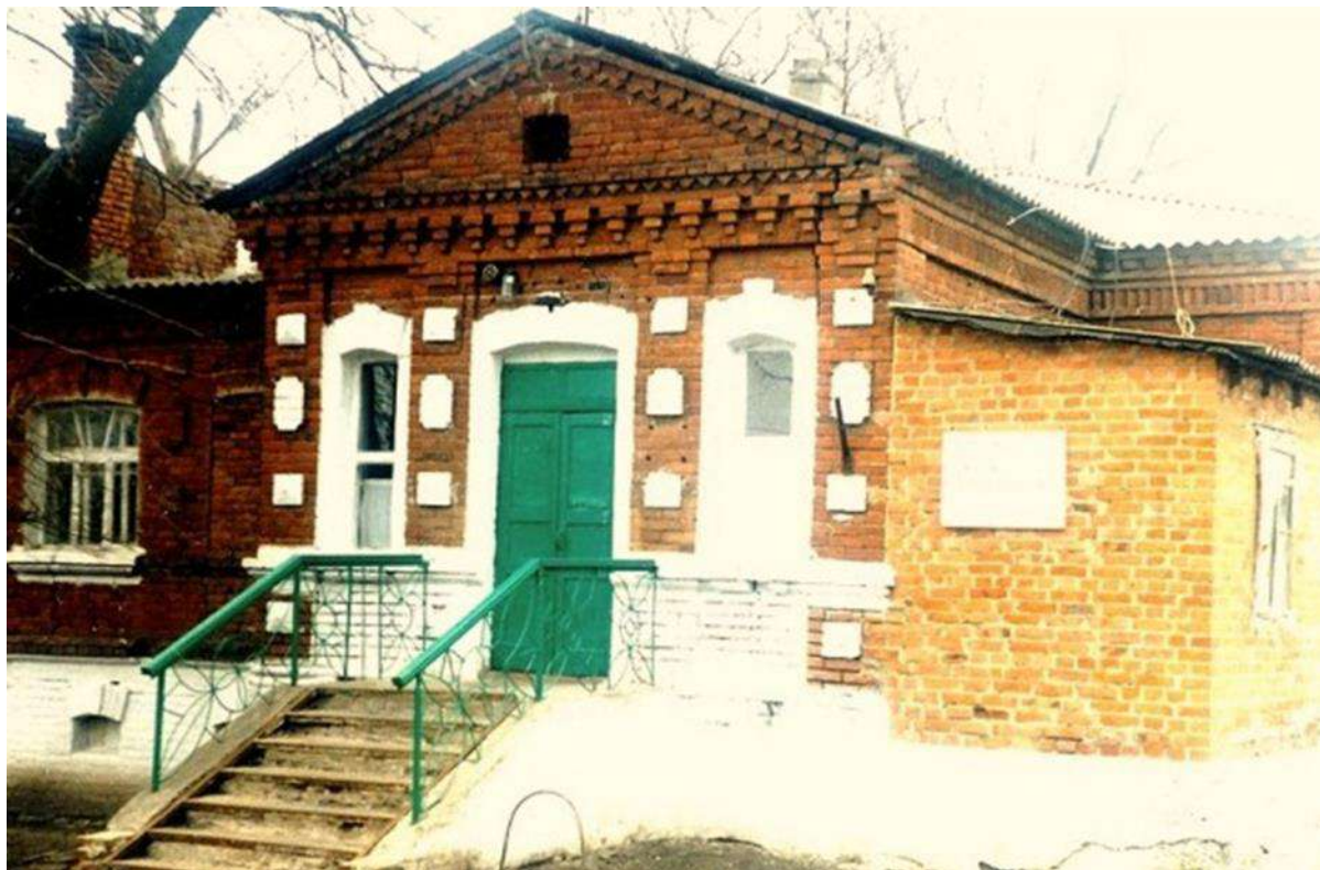
Вот таким был дом Цукурова до капитального ремонта...
